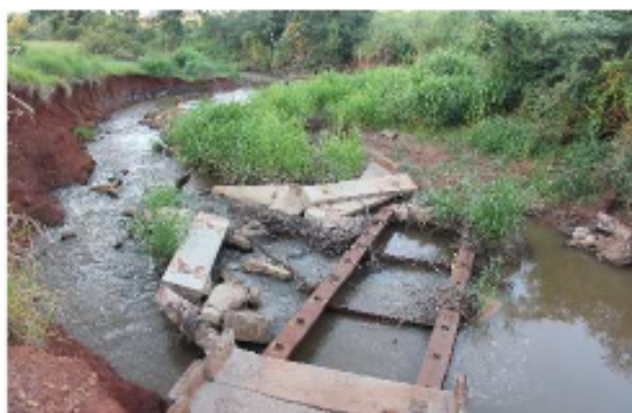
Travessões com estrutura comprometida
